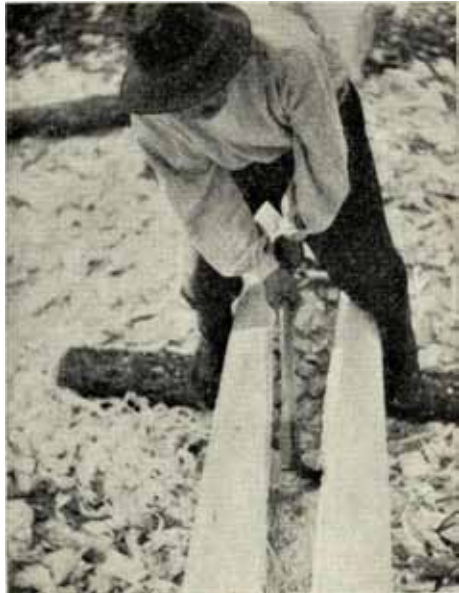
Kuva 6. Tehon käyttöä telsouksen alussa.
