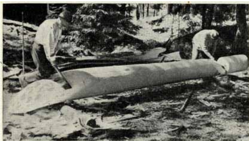
Kuva 4. Ensinnä veistettiin perä ja keula kirveellä valmiiksi.
