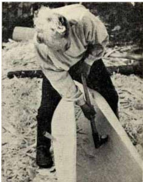
Kuva 7. Lopputelsouksessa veistetään ohuita lastuja.
